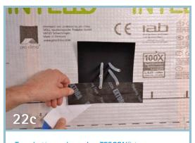
Tape bottom edge using TESCON® tape
